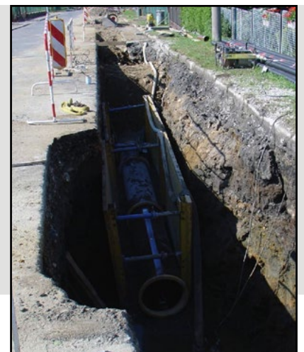
uloženie potrubia z kameniny DN 400
