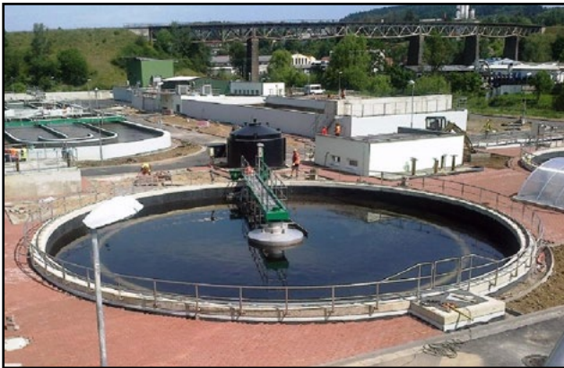
odovzdaná stavba 9A Velké Mezříči – ČOV
