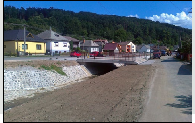
úprava Hlbokého potoka v obci Brestov
