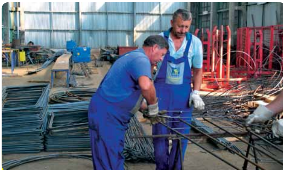
Pracovníci ohýbarne sa v týchto mesiacoch nenudia. Michal Bendžúch a Václav Havrila, majú okrem klasickej prípravy železných konštrukcií, plné ruky práce aj s panelmi.
