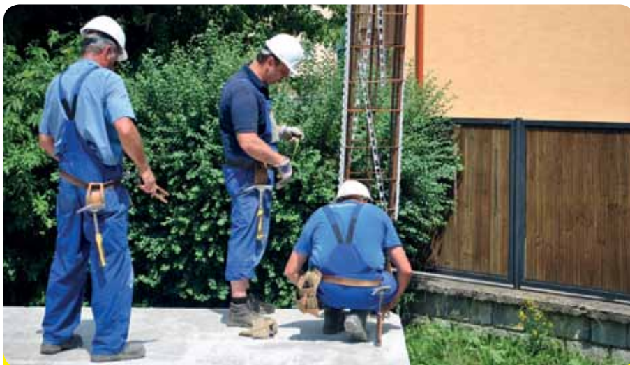
Chlapi na stavbe skeletu administratívnej budovy spoločnosti DÚHA Prešov.
