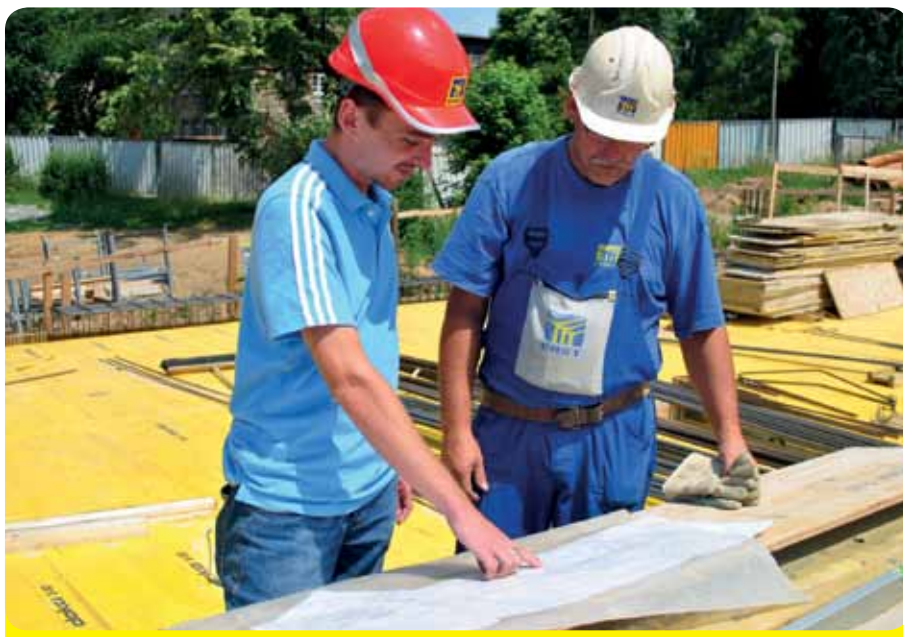
Stavebná porada stavbyvedúceho Ing. Michala Bedaja a vedúceho tesárskej partie Michala Rákociho.
