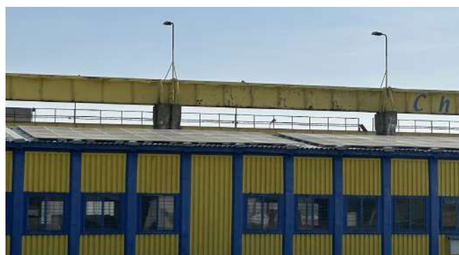
Panely na streche
