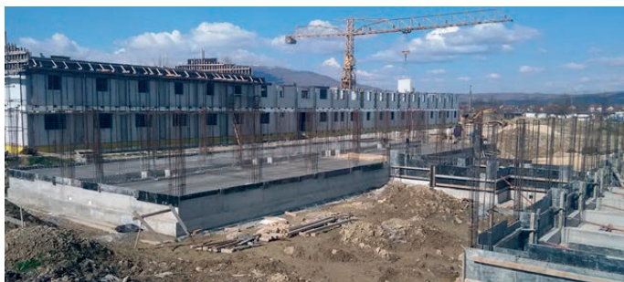
Výstavba v marci 2015
