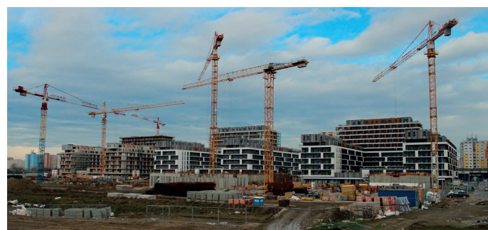
Výstavba Južného mesta - Zóna Mesto, Bratislava (december 2017)
