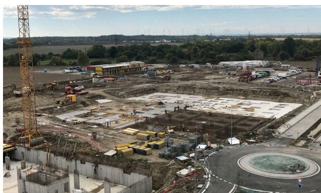
JM, Základy bytového domu B2
