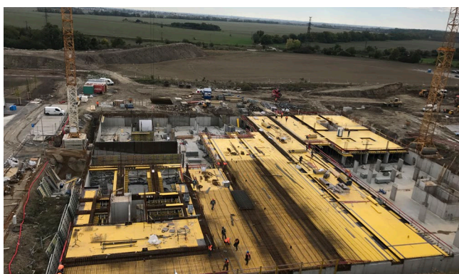
JM, Základy bytového domu B1
