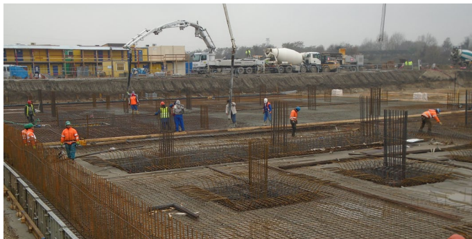
Betónovanie základovej dosky
