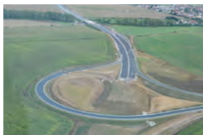
Začiatok úseku R2 Zvolen - Pstruša
