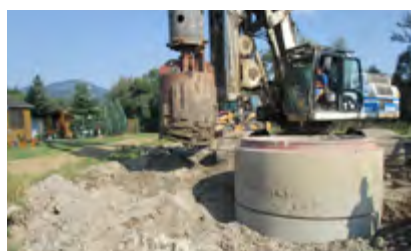
Zakladanie studne s pomocou pilotovacej súpravy.
