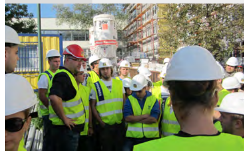
Stavba Internáty Mlyny
