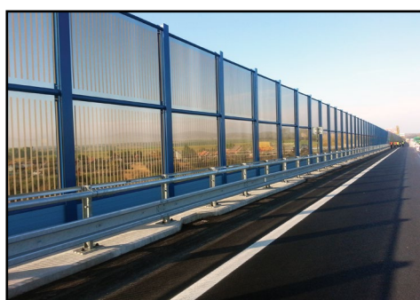
protihluková stena na moste
