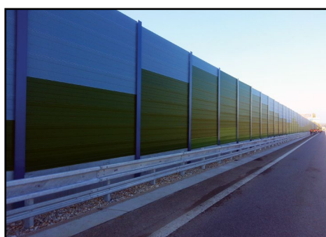
protihluková stena mimo mosta
