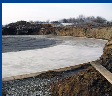
Stavebné práce na Bioplynovej stanici Sačurov XII/2012 - VIII/2013
