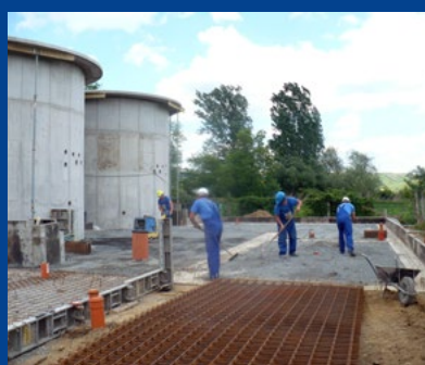
Čaklov - zvýšenie kapacity ČOV I/2013 - VII/2014
