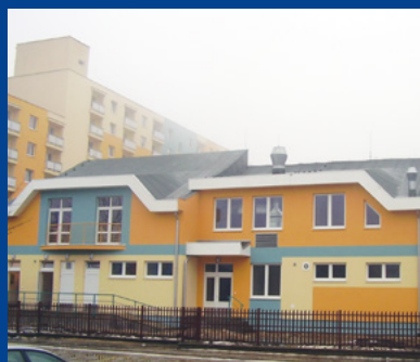
„Prístavba a rekonštrukcia zariadenia pre seniorov v Michalovciach“ VIII/2011 - VI/2013
