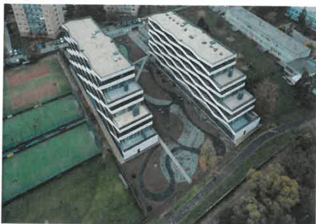
Bytový dom s polyfunkciou LAGO II.etapa, Košice
