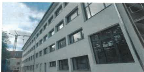
Rekonštrukcia internátu a telocvične SOŠ lesníckej v Bijacovciach
