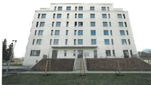
Bytový dom Plavisko – I.etapa, Ružomberok
