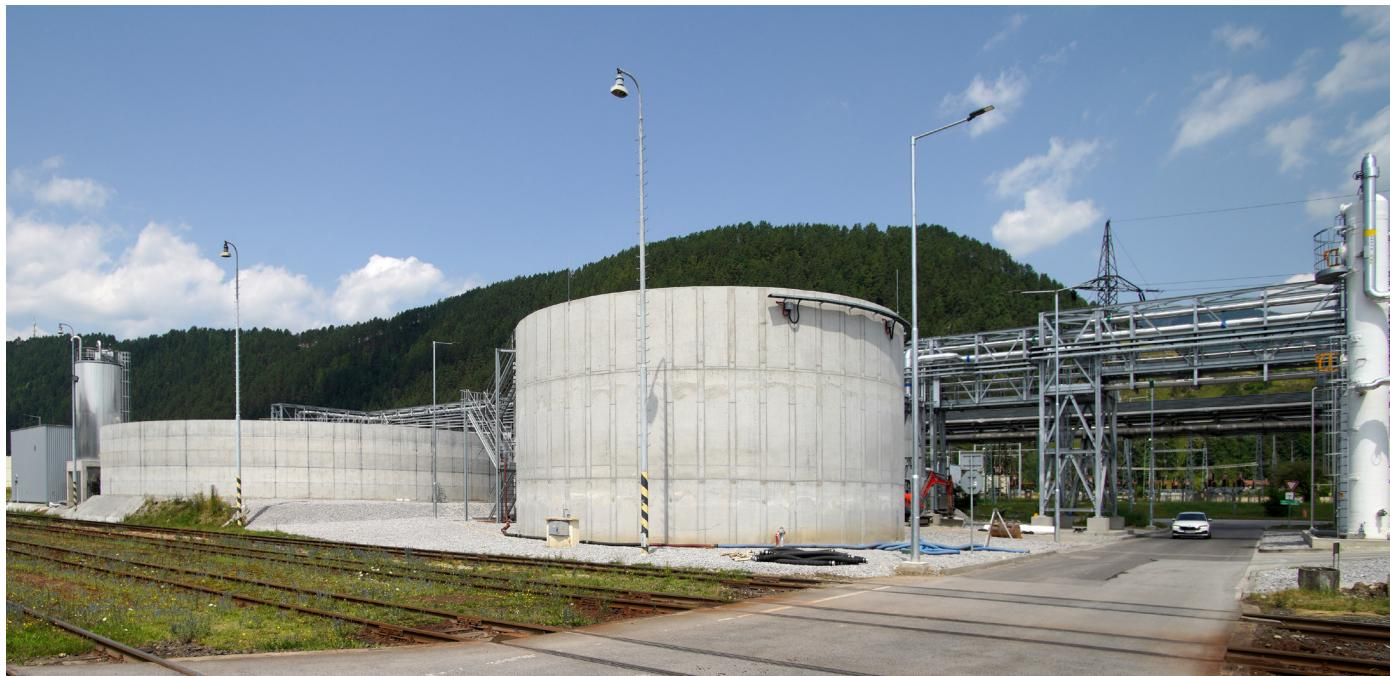
Predmetom projektu bola novostavba čistiarne odpadových vôd (ČOV) a úpravne vody, ktorá zabezpečuje čistenie a úpravu vody pre nový papierenský stroj PM19. Súčasťou ČOV a úpravne vody sú štyri prevádzkové objekty (budovy), päť kruhových nádrží a štyri mohutné základy pre osadenie technologických zariadení a nádrží.
